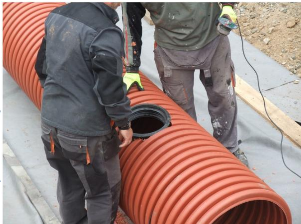
Spojka IN-SITU – včetně pryžové těsnící manžety
