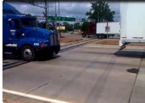
The Huron Church crossing in Windsor Ontario – 12 000 nákladních automobilů za den, realizace 1992, výměna kolejnice po 22 letech.
